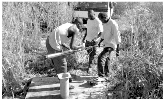
Il pozzo da 110 mt. con pompa, fatto dagli stessi studenti.
