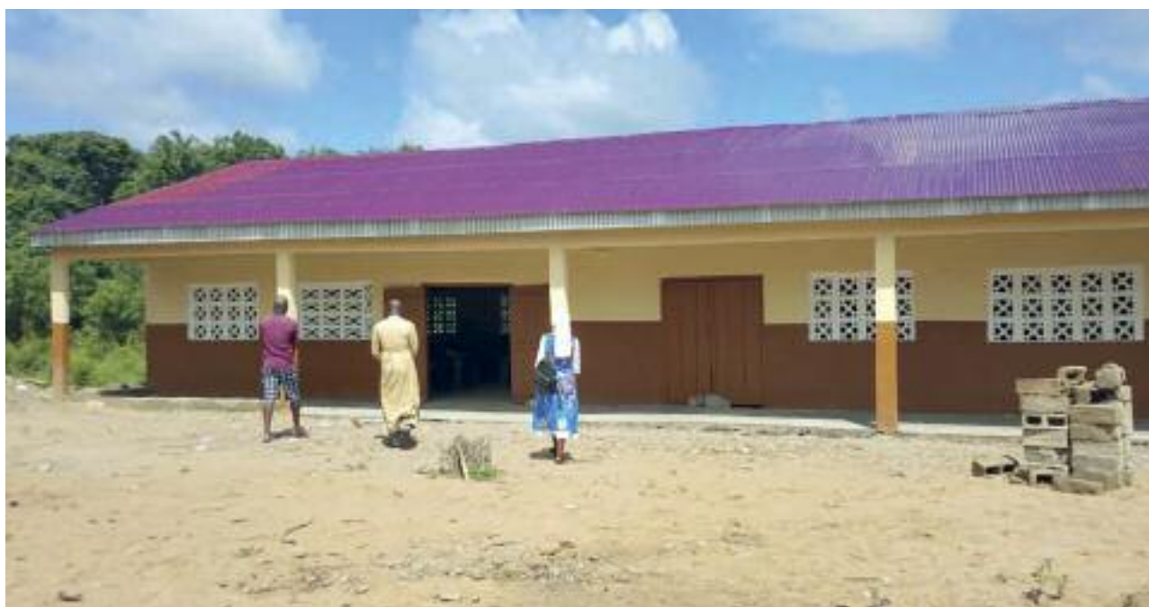
M.G21 – RISTRUTTURAZIONE SCUOLA ELEMENTARE - KPANAN – COSTA D'AVORIO
