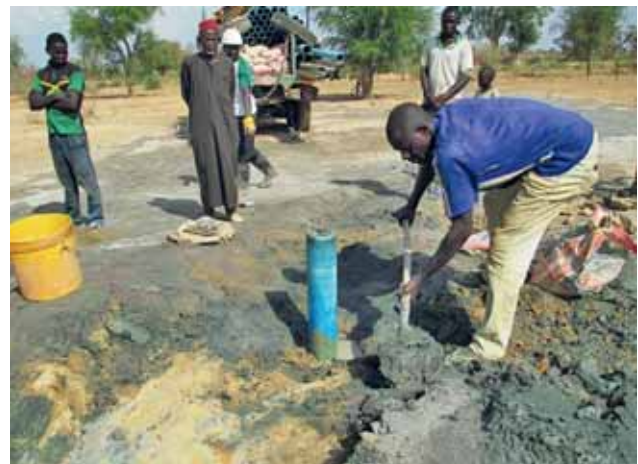
Lavori per Pozzo - Suor Myriam Bovino - Mali
