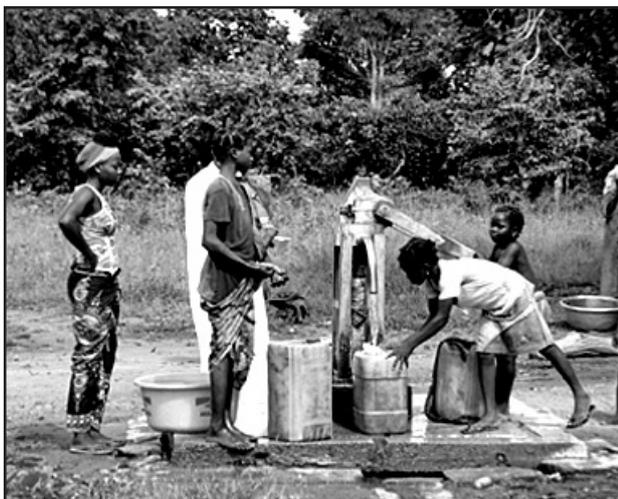
La pompa non aveva il muro di cinta, gli animali del villaggio la sporcavano e l'acqua di scolo favoriva il moltiplicarsi delle zanzare. Inoltre il getto dell'acqua era debole, perché da anni non si faceva manutenzione al corpo della pompa.
