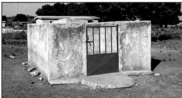
In dicembre 2012 abbiamo ricostruito il muretto, riparato la lastra di cemento del pavimento, attraverso cui l'acqua piovana e le impurità filtravano nel pozzo. Abbiamo rimesso in funzione la pompa, sostituendo le numerose parti rovinate.
